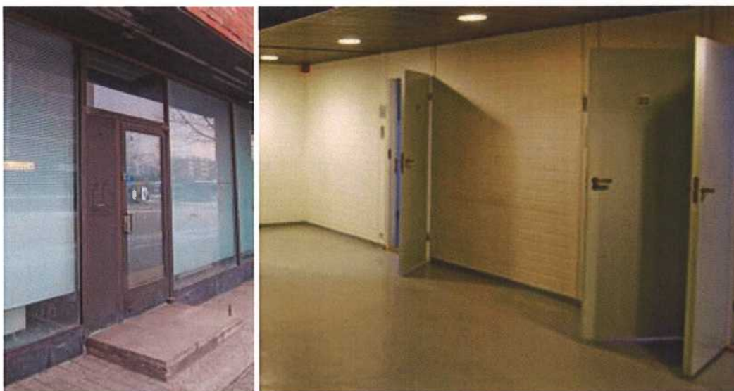
Kuva 4-15 Ensimmäisen kerroksen sisäänkäynti ja kolmannen kerroksen laakaovia.
