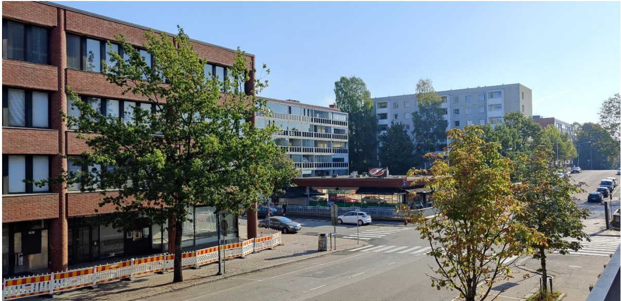
Kuva 11. Kotkankadulla rakennusten massoittelu ja asettelu on vaihtelevaa. Näkymä Kotkankadulta etelään.
