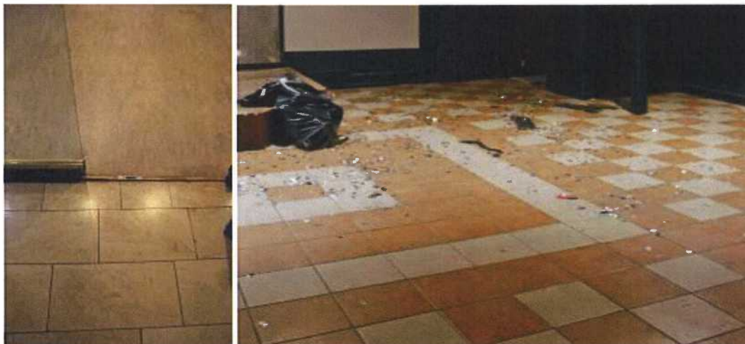
Kuva 4-166 Pankkisalnin ja myymälätilan lattiamateriaalit sekä kellarikerroksen keraamiset laatat.
