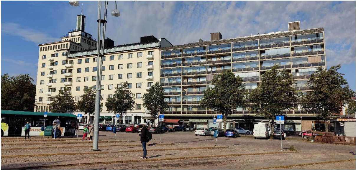
Kuva 14. Kuvassa vasemmalla Hotelli Meritorni sekä oikealla Kymenlaaksonkatu 18, jotka yhdessä muodostavat Katariinantoria pohjoisessa reunustavan korkean muurin.
