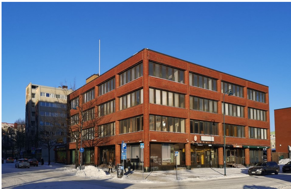
Kuvateksti: Kotkankatu 10, punatiilinen pankkirakennus etelästä.
