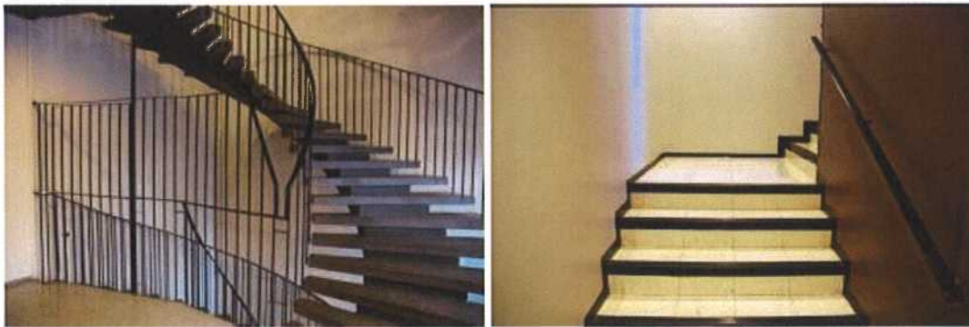
Kuva 5-16 A- ja B-porraskäytävät.
