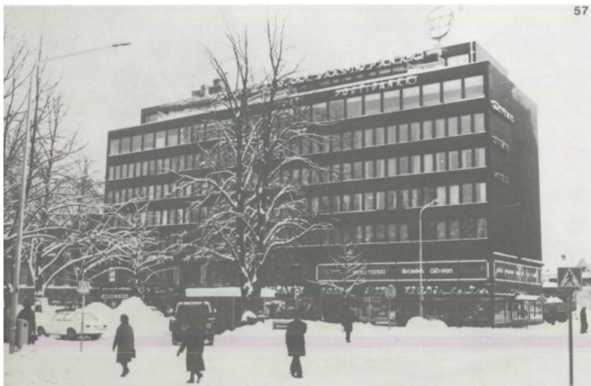
Kuva 21. Kookas STS:n talo valmistui Keskuskadulle vuonna 1961. (Kotkansaaren merkittävät ympäristöt ja rakennukset 1982)
