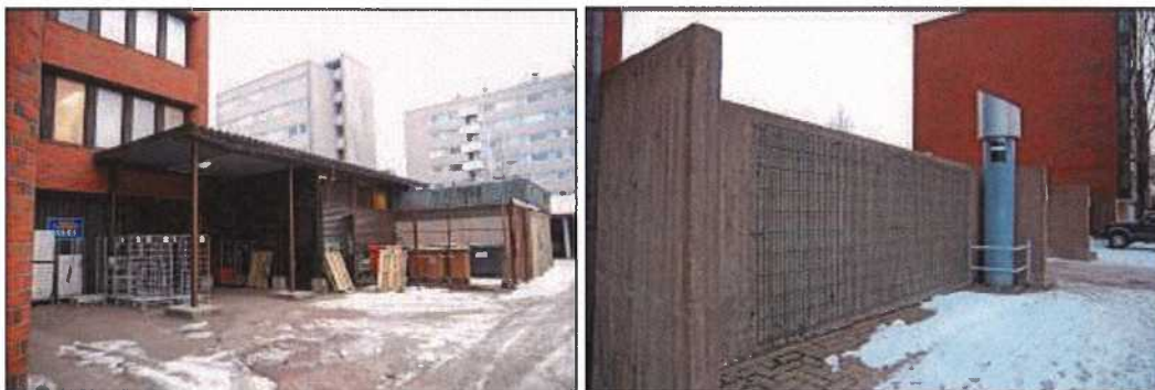
Kuva 5-19 Sisäpiha sekä sitä reunustava betoniaita.
