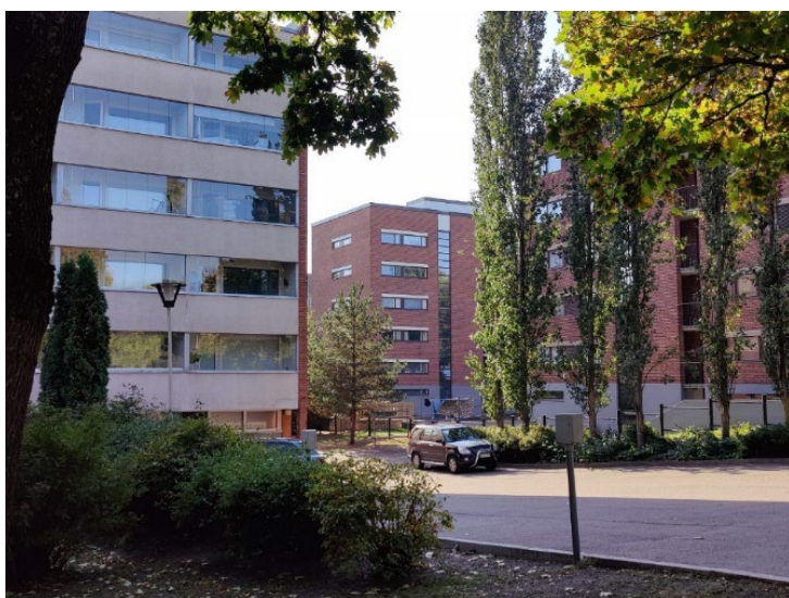
Kuva 16. Kotkansaaren rakennuskannasta löytyy runsaasti 1960- ja 1970-lukujen punatiilisiä rakennuksia. Kuvassa Kymenlaaksonkadun ja Puutarhakadun kerrostaloja linja-autoaseman länsipuolella.
