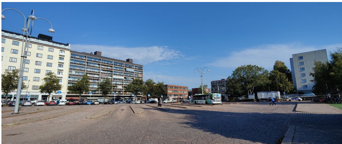
Kuva 15. Katariinantorilta katsottuna Kotkankatu 10 jää alisteiseksi korkeimmille kerrostaloille ja paikoin se jää myös kasvillisuuden peittoon. Torin vastakkaiselta laidalta Puutarhakadulta tarkasteltuna Kotkankatu 10 jää kasvillisuuden peittoon.
