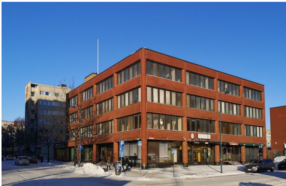
Kuvateksti: Kotkankatu 10, punatiilinen pankkirakennus etelästä.
