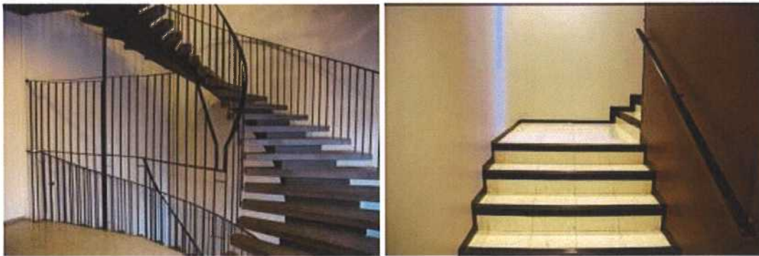
Kuva 5-16 A- ja B-porraskäytävät.
