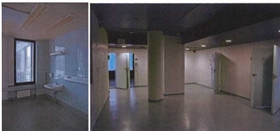
Kuva 5-14 Kolmannen kerroksen toimenpidehuone sekä käytävätila.
