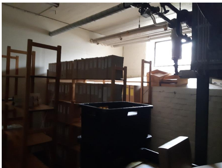
Kuva 1: Ehdotettu poistumistie ja savunpoistoikkuna kellarissa.
